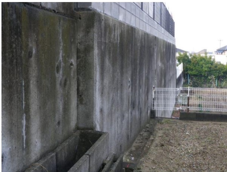
⑨擁壁全景(横から撮影)
